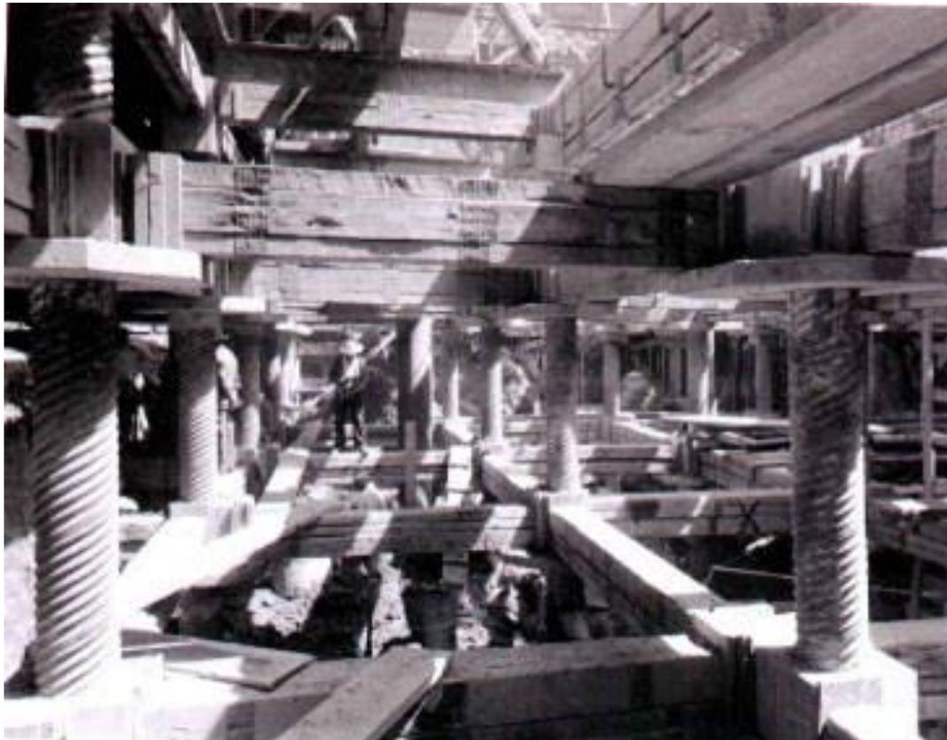
FOTO 11. HILERAS DE PILOTES DE APOYO AL CONTRAVENTEADO.
